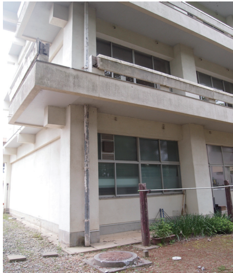
高萩高校で手すり崩落
