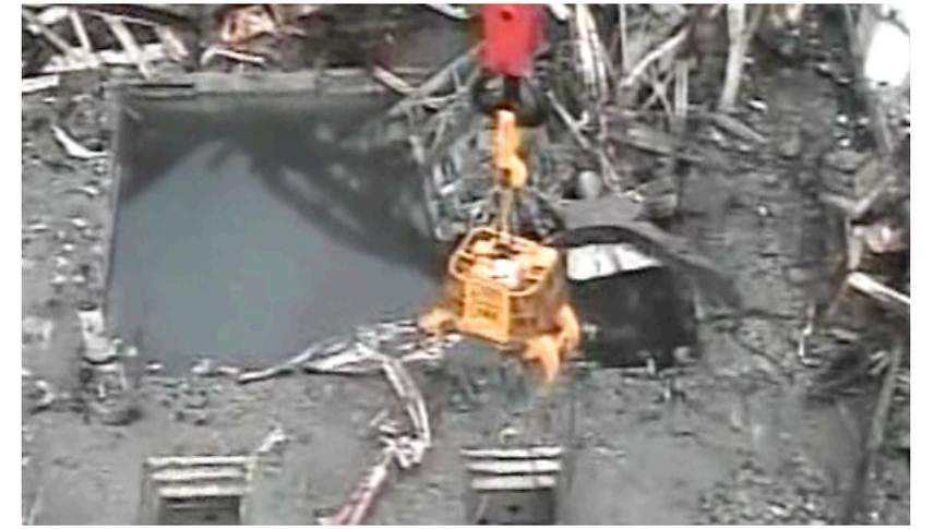
【図1】3号炉建屋上半部での瓦礫撤去作業 左上の水面が核燃料プール
